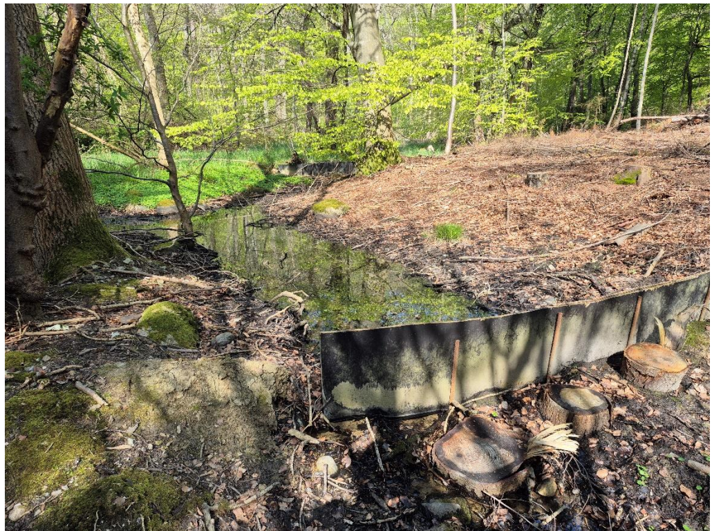
Figur 6 Afløbet fra mosen ved nr. 24 med en af de tidligere udførte opstemninger
