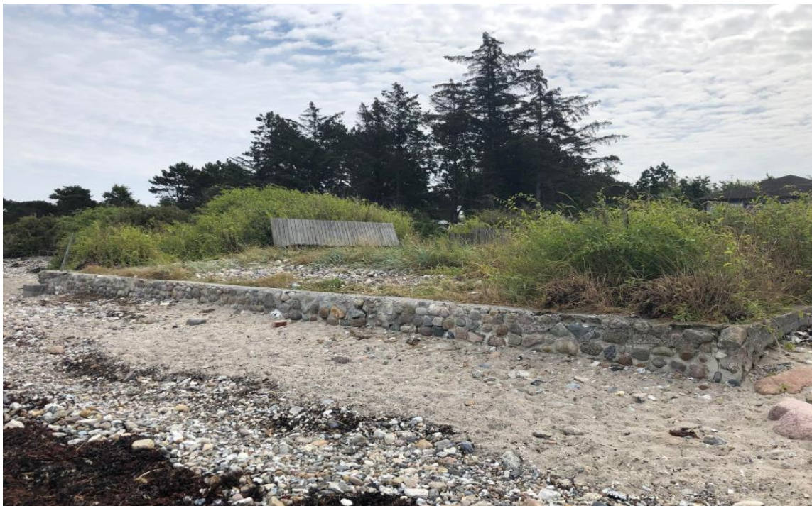
Figure 2 Støttemur på matrikel 112b, Plantagevej 26
