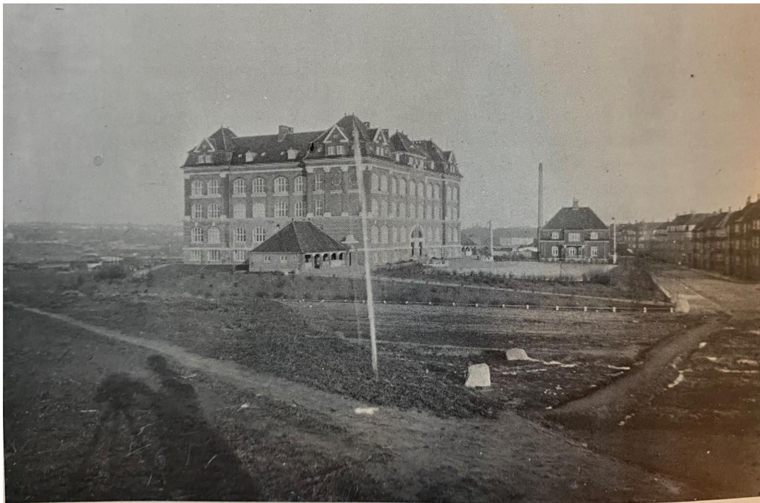
Læssøesgades skole set fra syd fot. omkr. 1921, Lokalthistorisk Samling.
