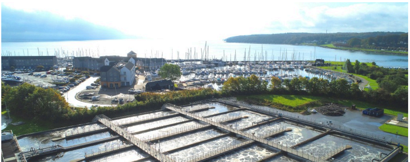
Marselisborg Renseanlæg. Foto: Aarhus Vand
