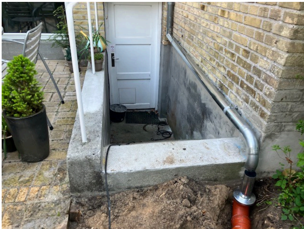
Eksempel på kældernedgang med forhøjet kant
