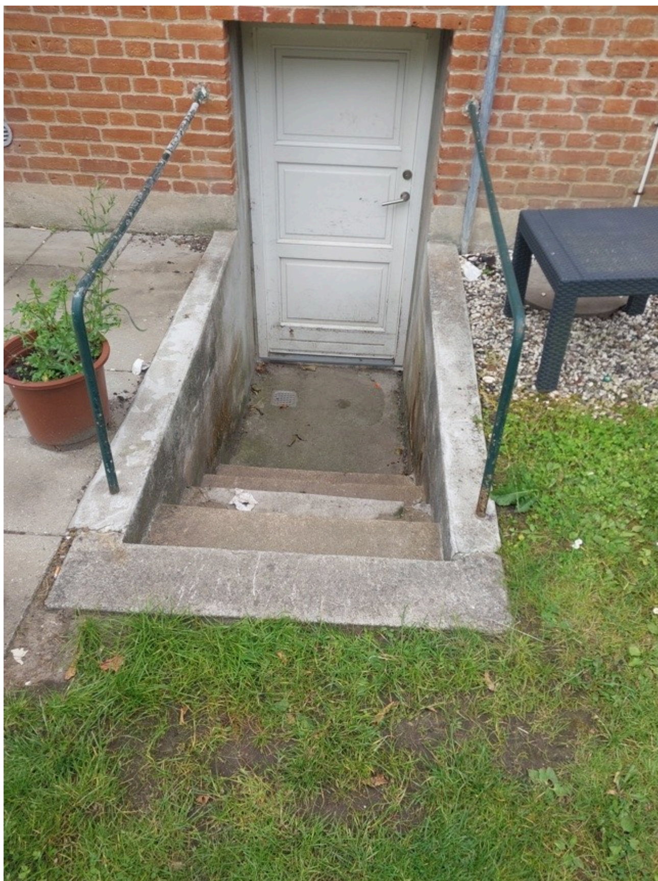
Eksempel på kældernedgang uden forhøjning
