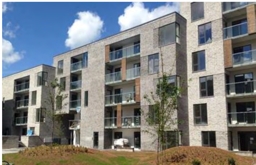
Eksempel på udvendige adgangsveje i bebyggelsen 'Bryggerhaven', Ceresbyen, som vist i princip 3, med adgang til hhv. 2 og 3 lejligheder, hvor adgangsvejene fremstår som regulære altaner og ikke som gange. (Kilde: A. Enggaard)
