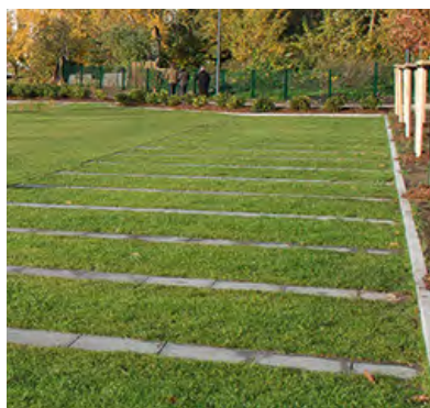
Plast-græsarmering, for maksimal grøn overflade, med flise markering imellem p-båse
