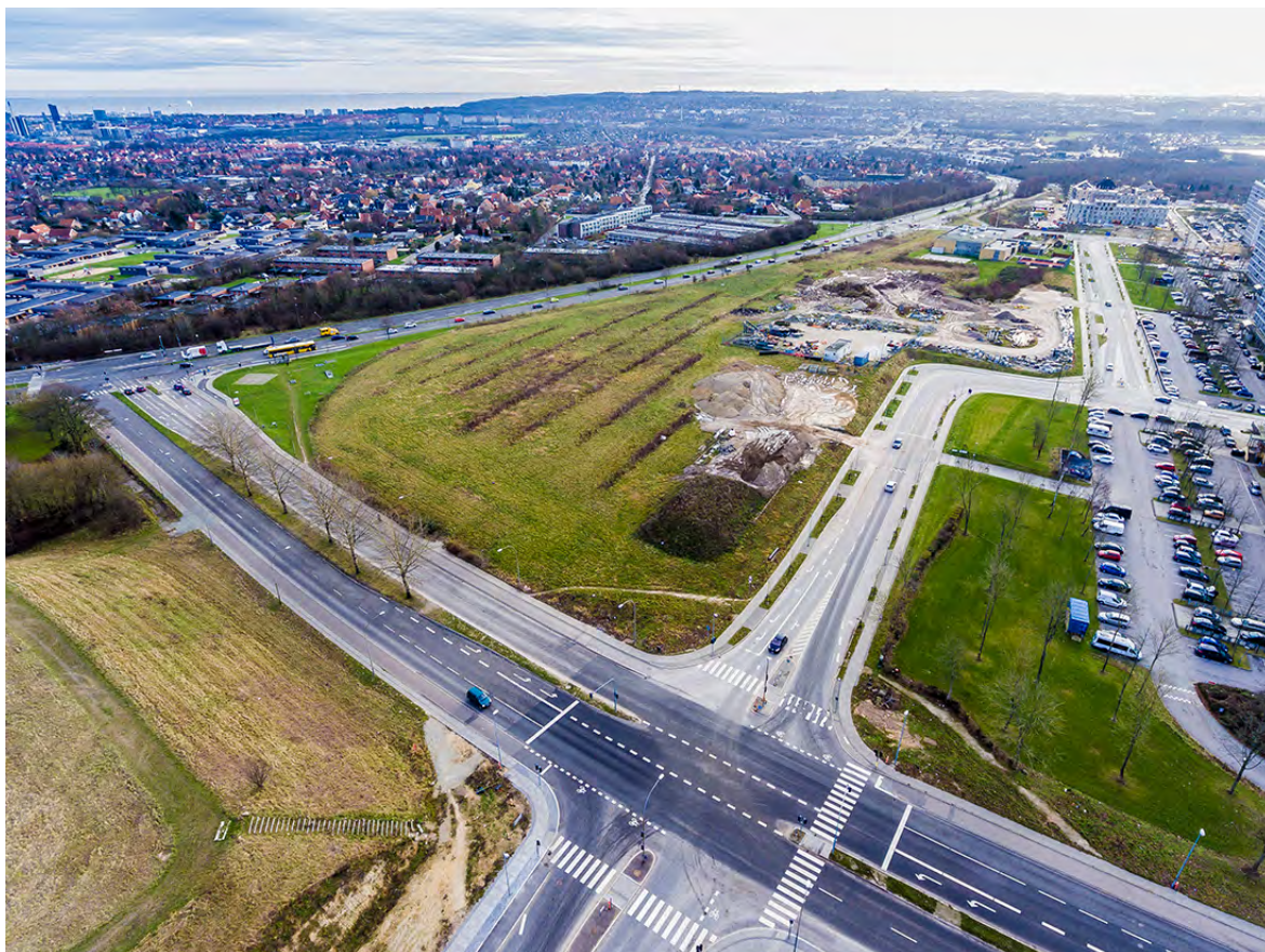
Luftfoto, som viser, hvordan området ser ud i dag - set fra Edwin Rahrs Vej i sydlig retning.
