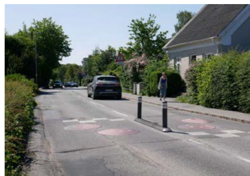
Virupvejs profil giver ikke meget plads til gående og cyklister, der skal færdes sammen med biler og busser.
