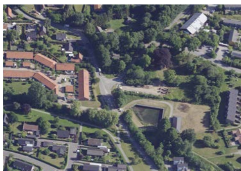
Østergaardsgrunden har siden nedrivning af Østergaard henligget som en delvis byggetomt, omkranset af forskellig bevoksning og med flere større træer, bl.a. den store Museblodbøg.
