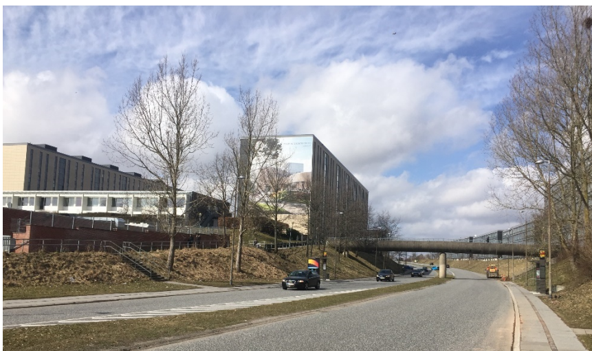
Foto set fra Rymarken, hvor gangbroen og voldanlæggene langs vejen ses.
