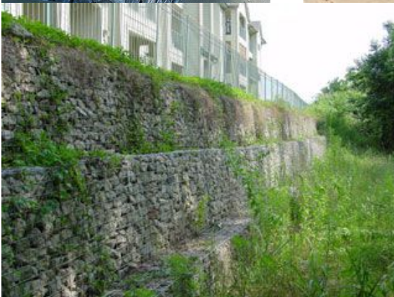
Eksempler på, hvorledes terrænmure kan udføres i genanvendt byggemateriale som fx beton, fliser og mursten og derved fremstå med et varieret udtryk.
