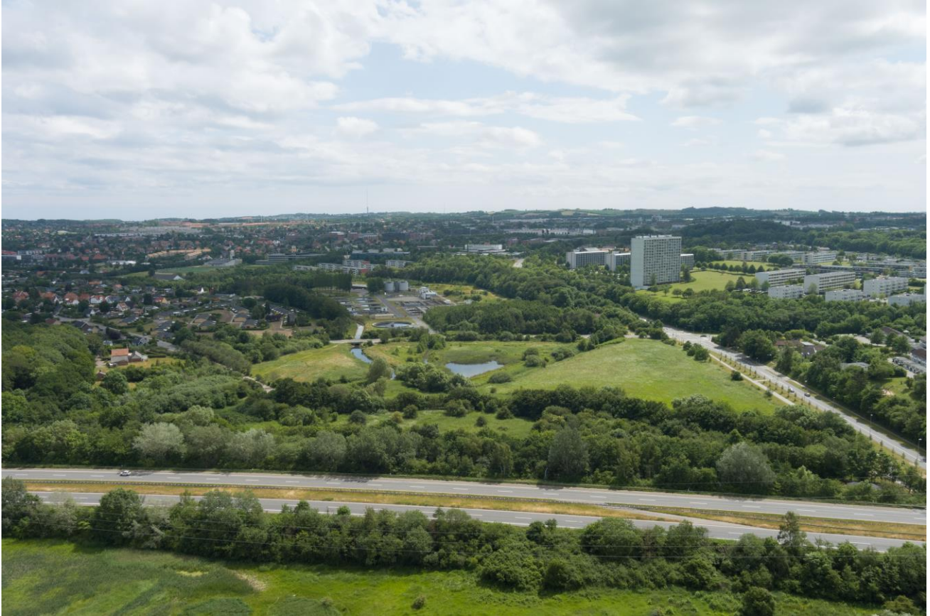
Figur 8.8: Drone 1, eksisterende forhold. Oversigtsbillede set fra nord mod syd (foto: NIRAS A/S).
