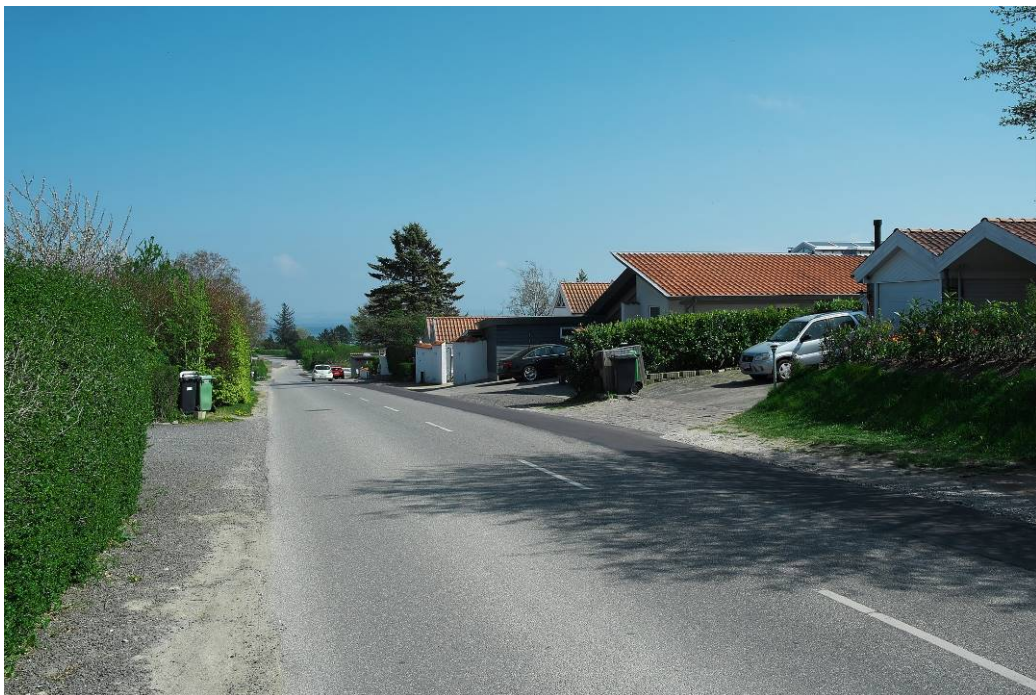
Den sydlige del set mod nord ad Strandvangsvej
