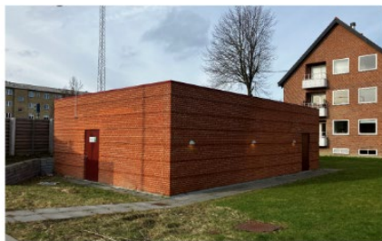
Pumpeanlæg ved Dybbølvej i Risskov.
