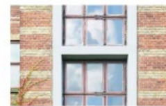
Lodrette vinduesbånd i markeret, pudset fals. Originale, rødbrune, gående partier og sorte karme. Lodposter og tværposter i vinduerne.
