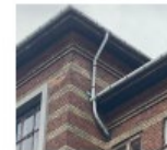
Nedløbsrør-"system" ift. form og udseende samt materialer i kobber, ubehandlet zink eller metal i kobberfarvet nuance.
