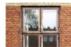
Originale vinduer kan bevares. Vinduer skal fremstå rødbrune, gående partier og sorte karme. Lodposter og tværposter i vinduerne.
