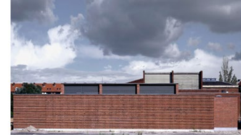
Foto: Gottlieb Paludan Arkitekter. Lindevang Transformestation
