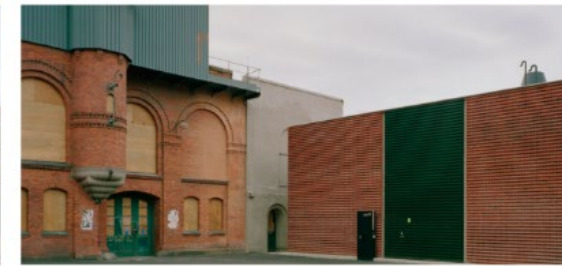
Foto: Gottlieb Paludan Arkitekter. Borergade Fiernkølecentral.
