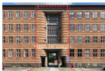
Portbygningens markante modulerede hovedindgang.
