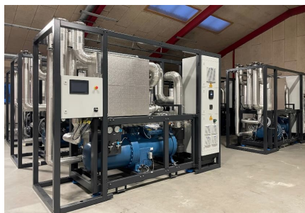
Figur 4-7 – Til venstre semi-hermetisk skruekompressor, Til højre varmepumpeinstallation vist uden indkapsling/hus.
