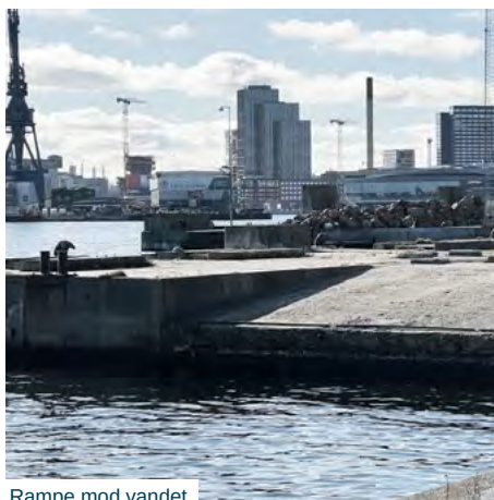
Rampe mod vandet
