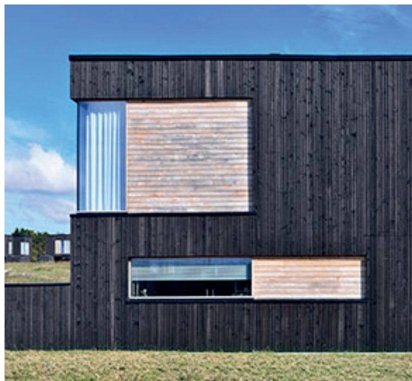
Recesser ved vinduer og skift mellem vandret og lodret beklædning samt farveskift.
