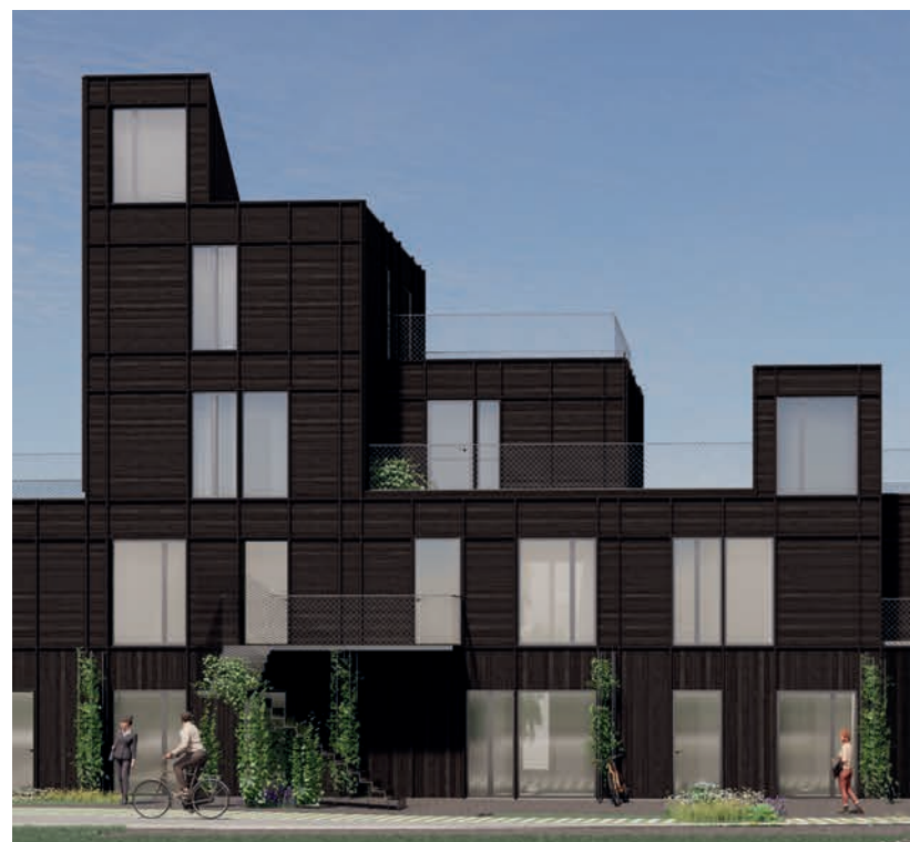
Variation i etagehøjde, skift mellem vandret beklædning i stueetage og lodret beklædning på øvre etager. Udvendt grid på facaden som detaljering.
