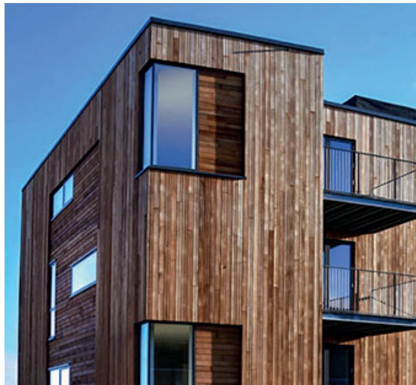
Recesser og skift mellem lodret og vandret beklædning
