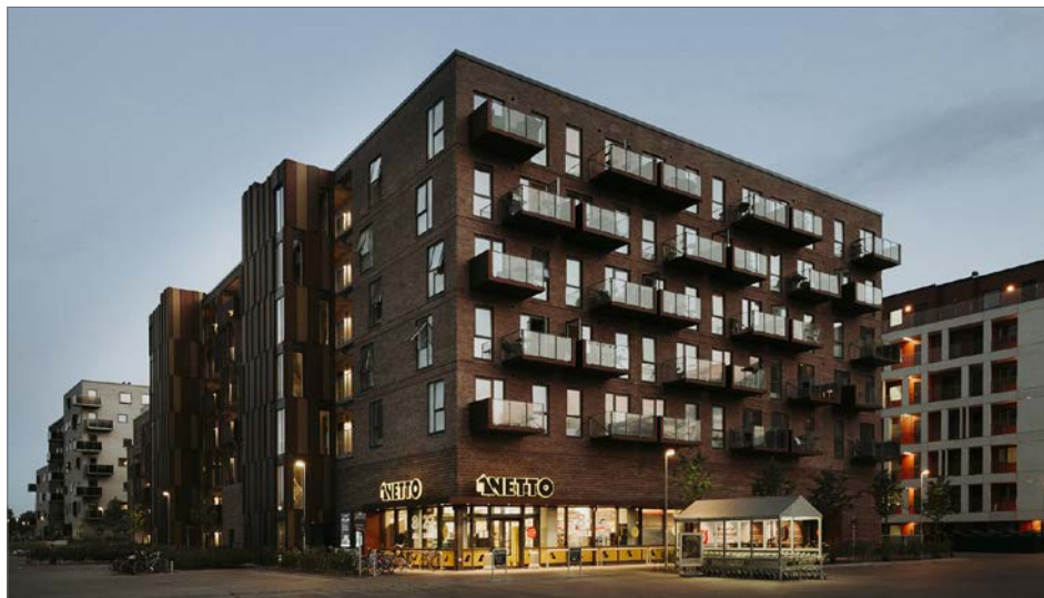
Foto: Lyskilte i stueetagen, Søren Frichs Vej
