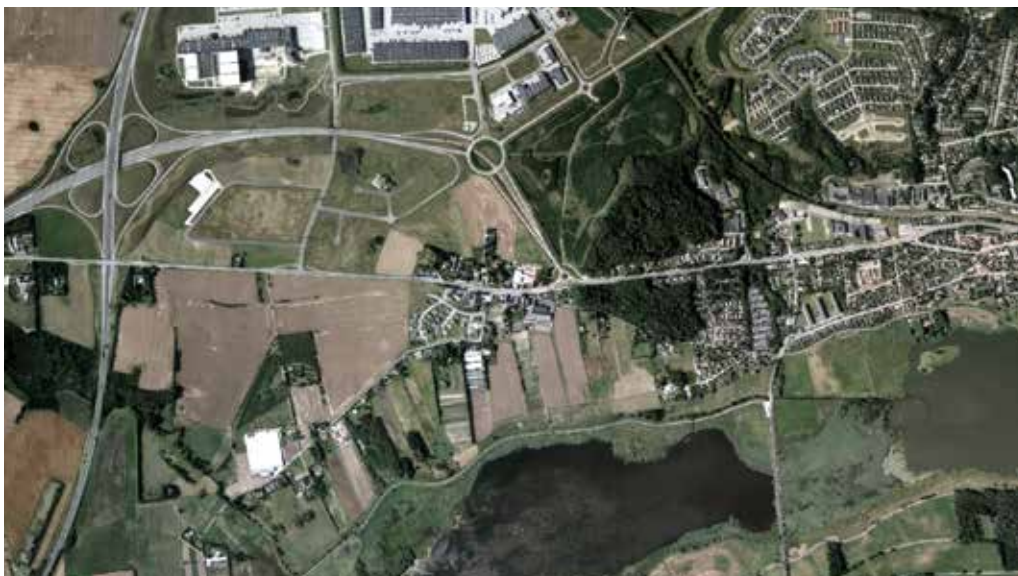
2012 Luftfoto - Logistikcentret udbygges og engsøen reetables
