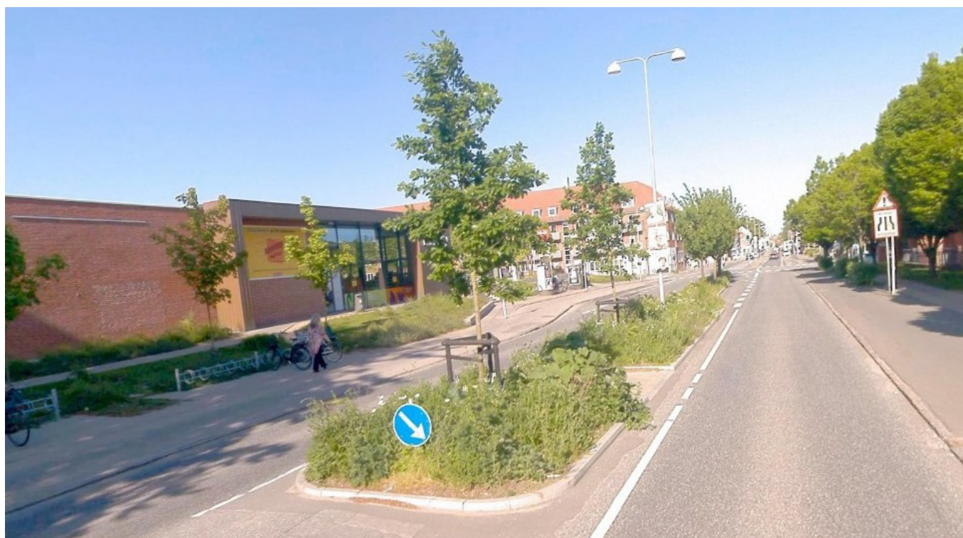
Figur 13. Eksempel fra Silkeborgvej hvor der er indarbejdet bedre krydsningsmulighed og mere grønt i vejrummet.
