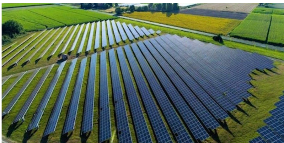
Figur 2. Eksempel på solpaneler fra et lignende anlæg
